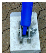
Fig. 14 Fodplade monteret og sikret.
